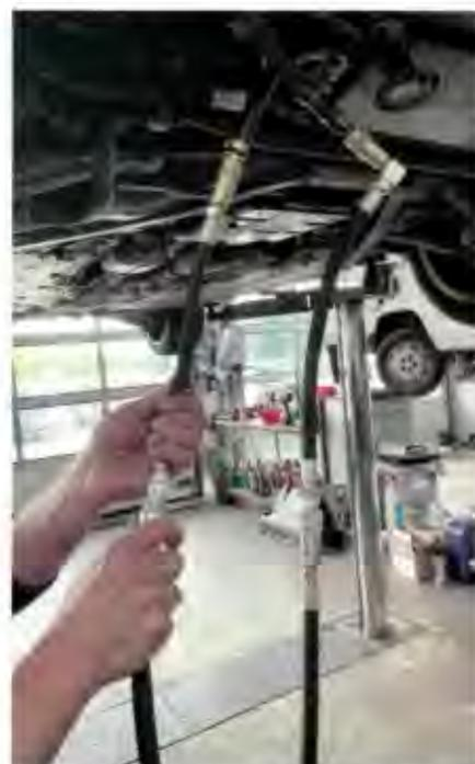
Mit fabrikatsspezifischen Adapterleitungen werden Vor- und Rücklauf des Ölkühlers direkt mit dem Liqui Moly Gerät verbunden.
