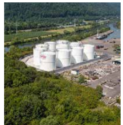
In zehn Tanks mit einer Gesamtfüllmenge von 18 Millionen Litern lagert das angelieferte Grundöl bis zu seiner weiteren Verarbeitung
